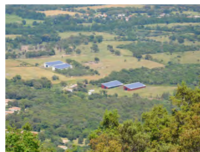
Hangars photovoltaïques dans la plaine
