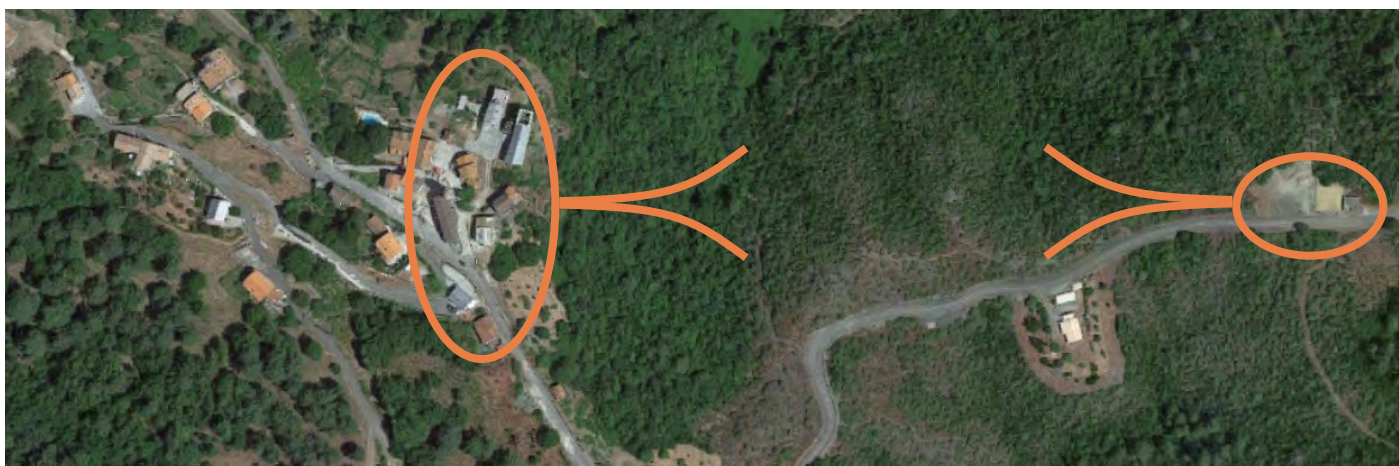
La zone de déchets et citerne, en covisibilité avec les points de vue du village vers les monts, la plaine et la mer
