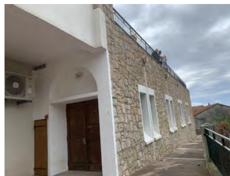
La salle polyvalente sous la place de l'église
