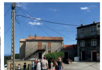
Solaro, réseaux aériens
