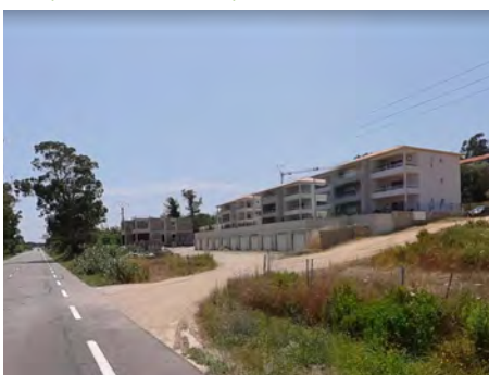
Nouveaux immeubles RT10
