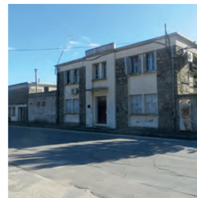
2, Ancienne usine d'Agnatellu
