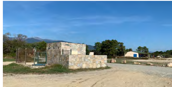
Local à poubelle et station de relevage
