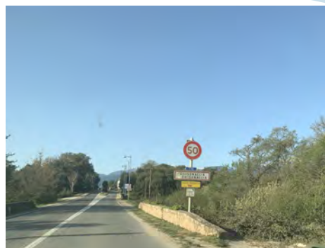
RT10 à l'entrée Nord de la commune
