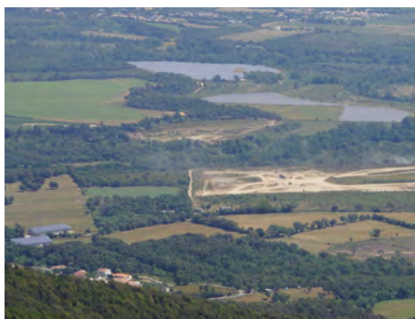
Hangars et parcs photovoltaïques récents
