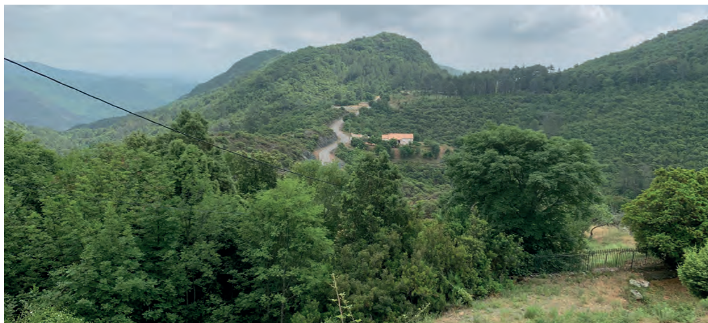
Vue sur la «nouvelle route» Ripete depuis le village de Lugo-di-Nazza
