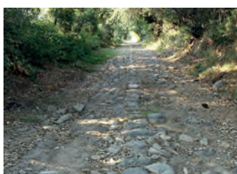
Strada romana soprana
