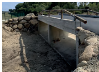
Aaménagements hydrauliques, Travu
