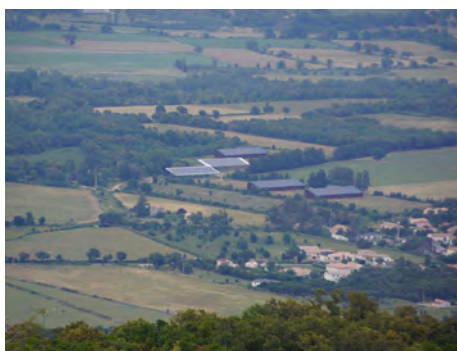
De récents hangars photovoltaïques
