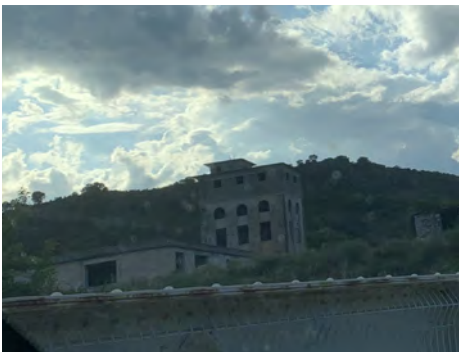
Complexe industriel de la Fortef
